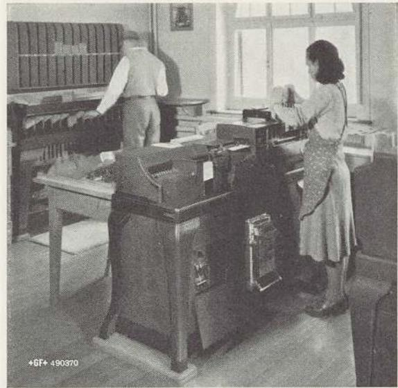
Bild 4 - Maschinenraum mit Sortiermaschine (Hintergrund) und einer der beiden Multipliziermaschinen
