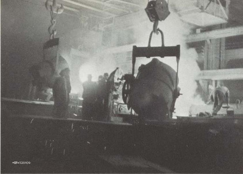
*Der Giessvorgang. Aus vier Kesseln werden über 50 To. flüssiger Stahl in die Sandform geleert*
