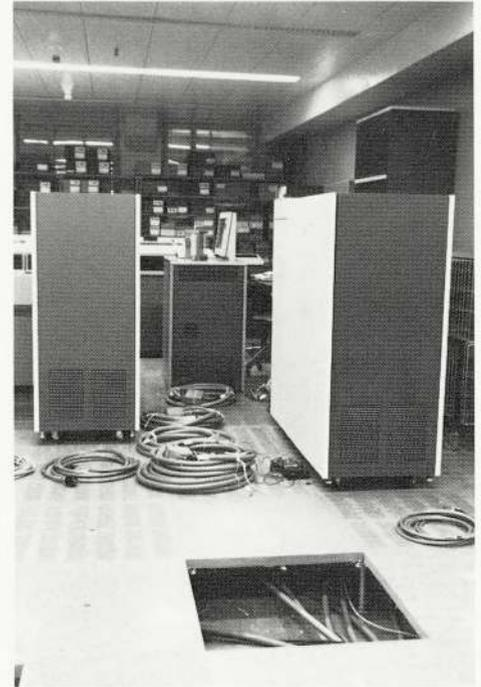
Der Standort ist vorbereitet. Die Verkabelung mit komplexem Zuleitungsdrahtwerk liegt in Kanälen unter dem Doppelboden.
