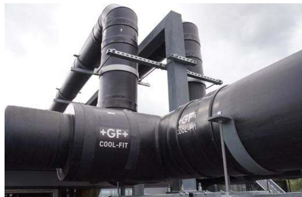
Vorisoliertes Rohrleitungssystem COOL-FIT für Anwendungen in der Lebensmittel- und Getränkeindustrie.
