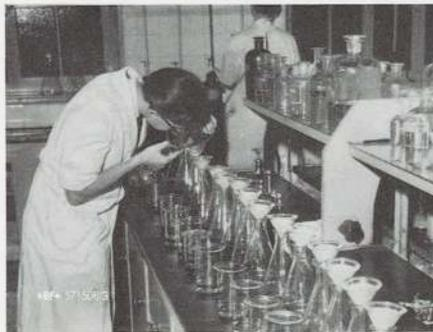
*Einfache Serienanalysen schulen die Selbstständigkeit, das Verantwortungsbewusstsein und die Handfertigkeit. Das Bild zeigt die Filtration im Verlaufe einer Siliziumanalyse in metallischen Werkstoffen.*
