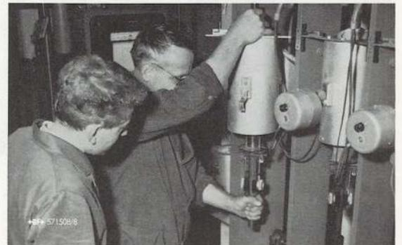
Zur Metallkunde gehört auch die Erprobung neuer Werkstoffzusammensetzungen. Das Bild zeigt den jungen Laboranten beim Erschmelzen und Vergiessen einer Versuchscharge.
