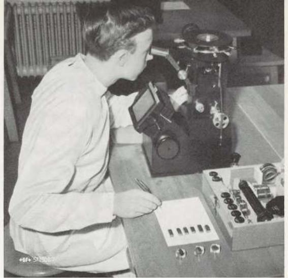
Nach der Grundschulung beginnt für den Laboranten metallkundlicher Richtung die Spezialausbildung. Der Lehrling auf dem Bild untersucht am Metallmikroskop das Gefüge verschiedener Stahlproben.
