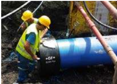
Die Versorgungsleitung der Wasserwerke führt direkt durch das Stadtzentrum.
