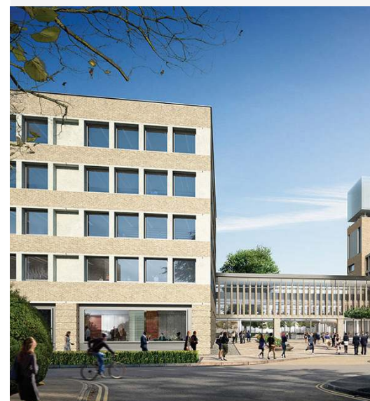
Im neuen Assessment-Center der University of Cambridge (UK) spielt Energieeffizienz eine zentrale Rolle. 2018 ist «The Triangle» bezugsbereit. (Bild: Cambridge Assessment Triangle Project Office).
